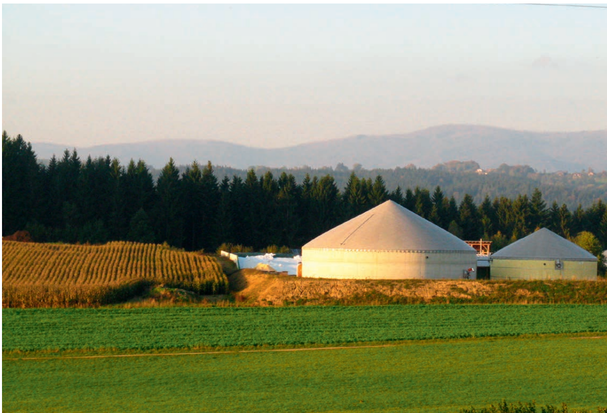
Abbildung 18: Nassfermentation – Fermenter, Nachgärer und Fahrsilo
